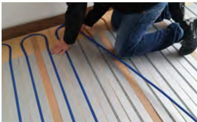
Randdämmungsstreifen/ Verlegeplatten Heizungsrohre/ Polsterhölzer gem. Systemhersteller verlegen.
