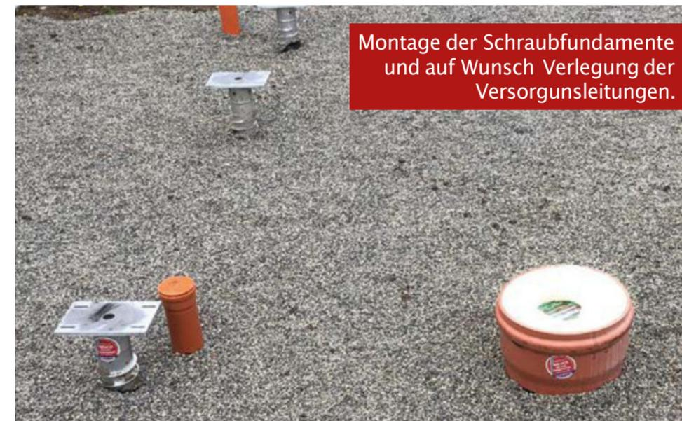
Montage der Schraubfundamente und auf Wunsch Verlegung der Versorgungsleitungen.
