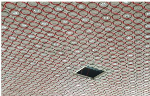
Positionierung des Heizkreisverteilers in die Zwischendecke. Zugang durch REVI-Klappe.
