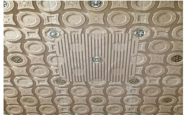
Deckenbelegung mit Hochleistungs-Lehmmodulen und Hochleistungs-Neutralplatten vor Rohrverlegung.
