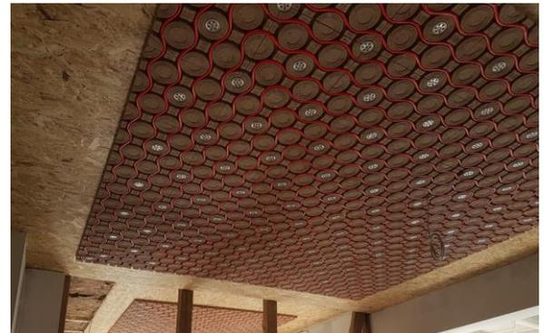
Deckensegel; die umlaufende inaktive Fläche wird nicht mit Lehmplatten belegt.
