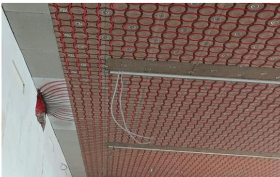
Niveaugleiche Integrierung des Ring-Schallabsorbers. Die Systemtrennung erfolgt mit handelsüblichen Putz-Eckschienen.
