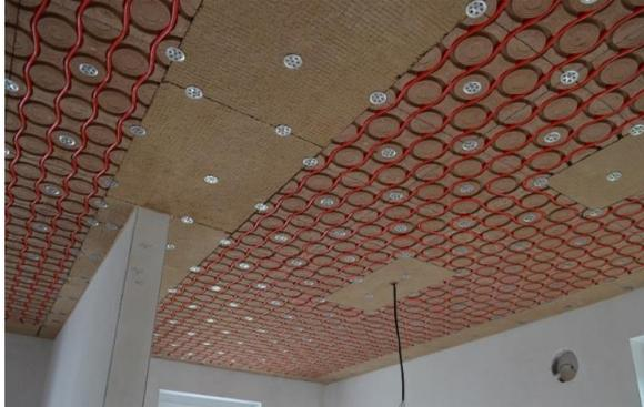
Deckenbelegung mit Hochleistungs-Lehmmodulen und Lehm-Platten nach Rohrverlegung.
