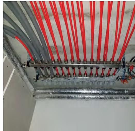
Die Rohre werden mit etwas Abstand vor der Revisionsklappe schräg durch die Montageebene zum Verteiler geführt. Den Abstand nicht zu weit wählen, da die Rohre in der Zwischendecke normgerecht isoliert werden müssen.
