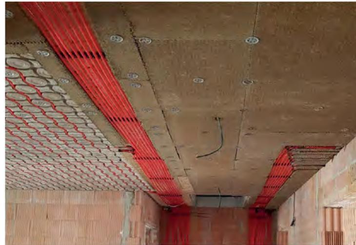
Niveaugleiche Anbindung durch eine Konstruktion aus 13 mm und 25 mm Lehm- bauplatten. An den 13 mm Platten werden die Rohre mit Edelstahl-Lochband befestigt. Decken- abschluss mit Lehm- oder Kalkputz.
