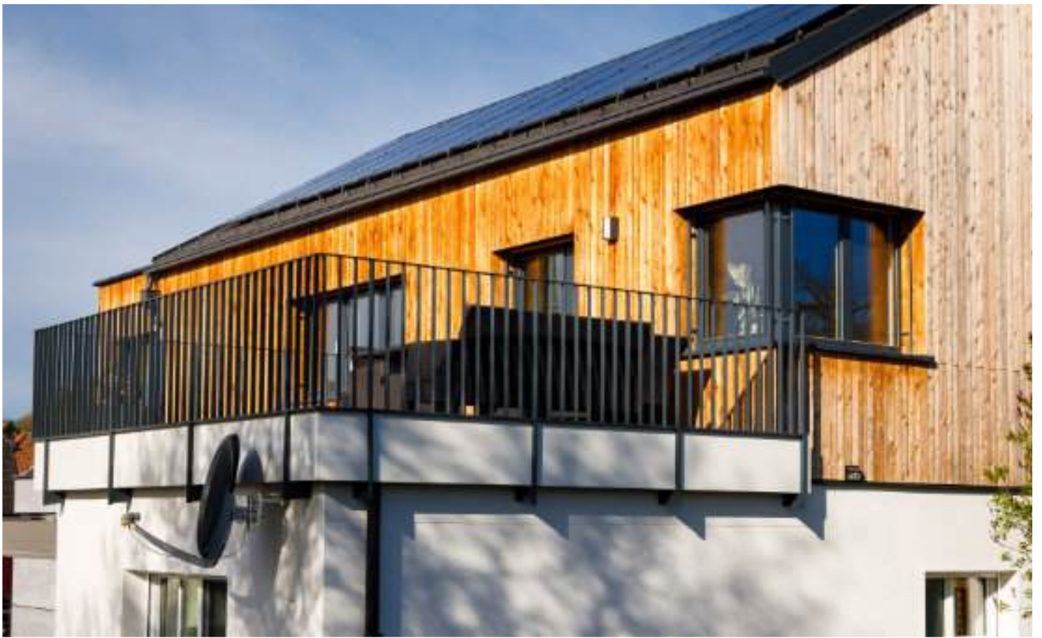
Terrassengeländer in Stahl verzinkt und lackiert
